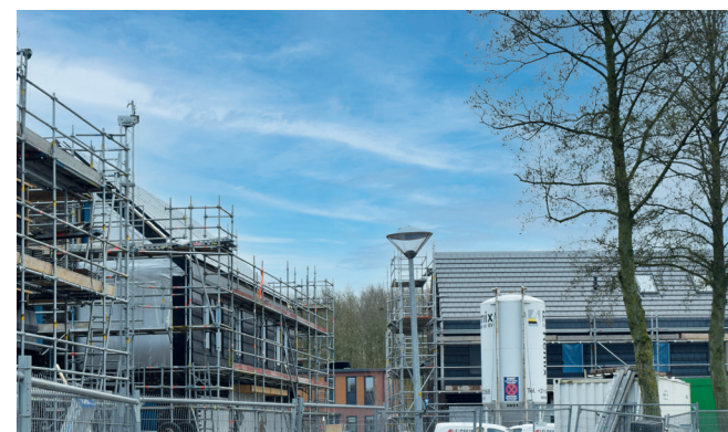
Versterking 8 woningen aan de Hink Oostingstraat 't Zand met Remix ER® Metselmortel en Strating geperforeerde strengpers stenen.
