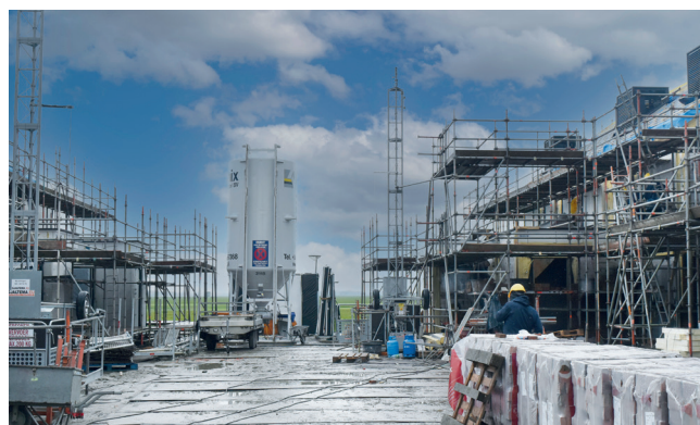
Sloop en nieuwbouw 30 woningen aan de Fazanthof te ten Boer met Remix ER® Doorstrikmortel in de kleur antraciet
