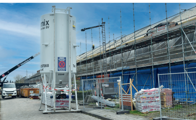
Renovatie 84 huurwoningen aan de Karel Doormanstraat te Bedum met Remix ER® Doorstrikmortel in de kleur antraciet en Strating geperforeerde strengpers stenen
