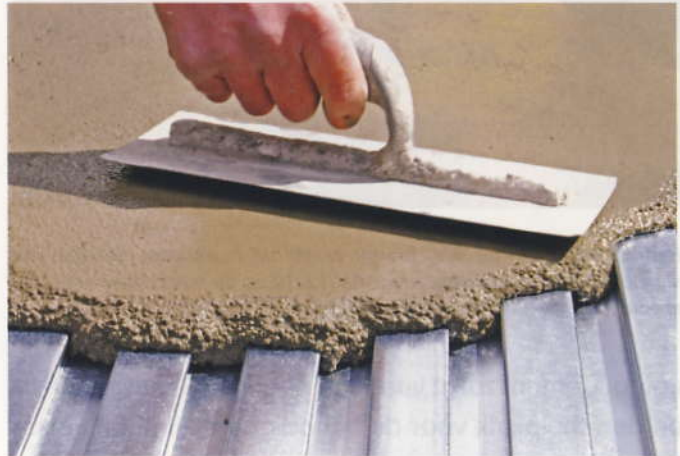
Met een volumieke massa van 1700 \text{ kg/m}^3 is deze mortel uitermate geschikt voor lichtgewicht betonvloeren op zwaluwstaartplaten.
