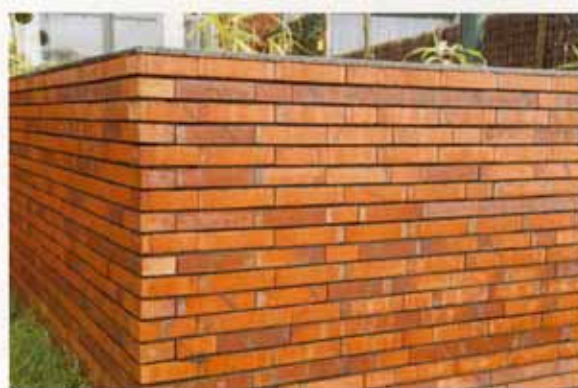
Serie van 61 woningen in Eelderwolde Aannemers: Rottinghuis en Ballast Nedam Mortel: doorstrijkmortel BM318 UA antraciet Steen: zeer zwakzuigend Gebouwd: 14 juni 2006
