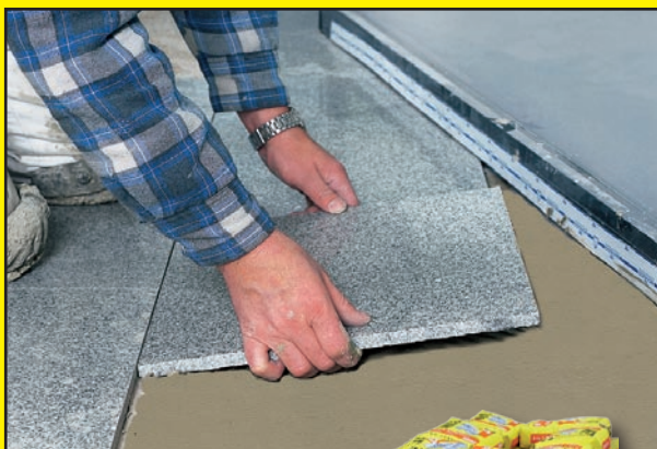
Tegels in de mortel zetten (wand- en vloertegels)
