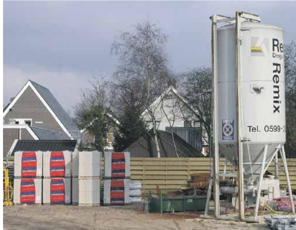
De Kimfix® mortel is speciaal ontwikkeld voor het stellen van de kimblokken als uitvlaklaag voor Calduran kalkzandsteen lijmblokken of elementen.
