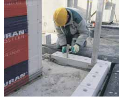
De Kimfix® mortel is speciaal ontwikkeld voor het stellen van de kimblokken als uitvlaklaag voor Calduran kalkzandsteen lijmblokken of elementen.
